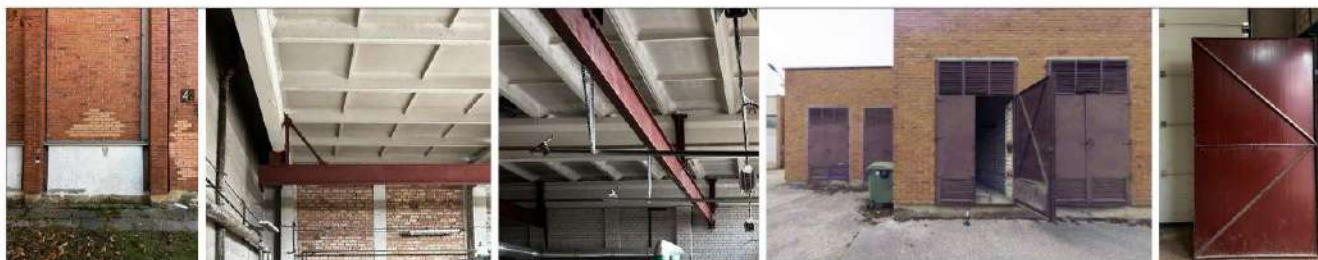
Esamų plytų ir metalo elementų spalvos
